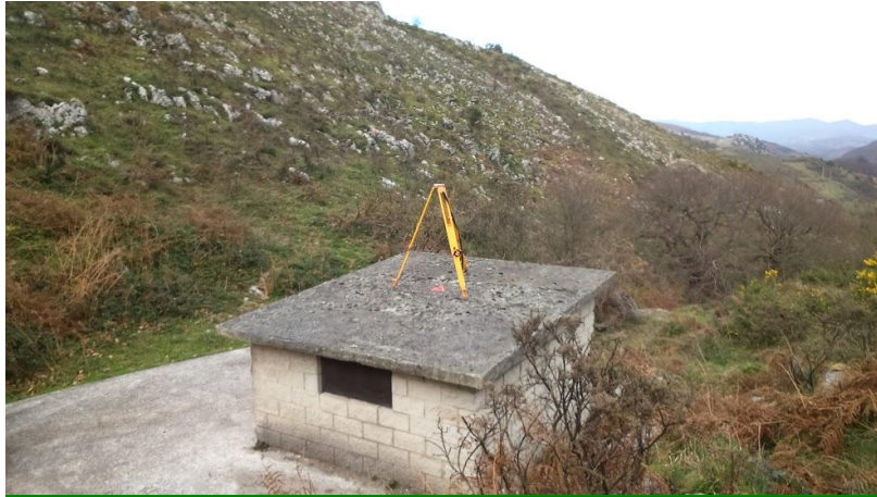
BASE-3: Situada a encima de la arqueta de rotura que hay al final de la obra. Materializada mediante pintura.
