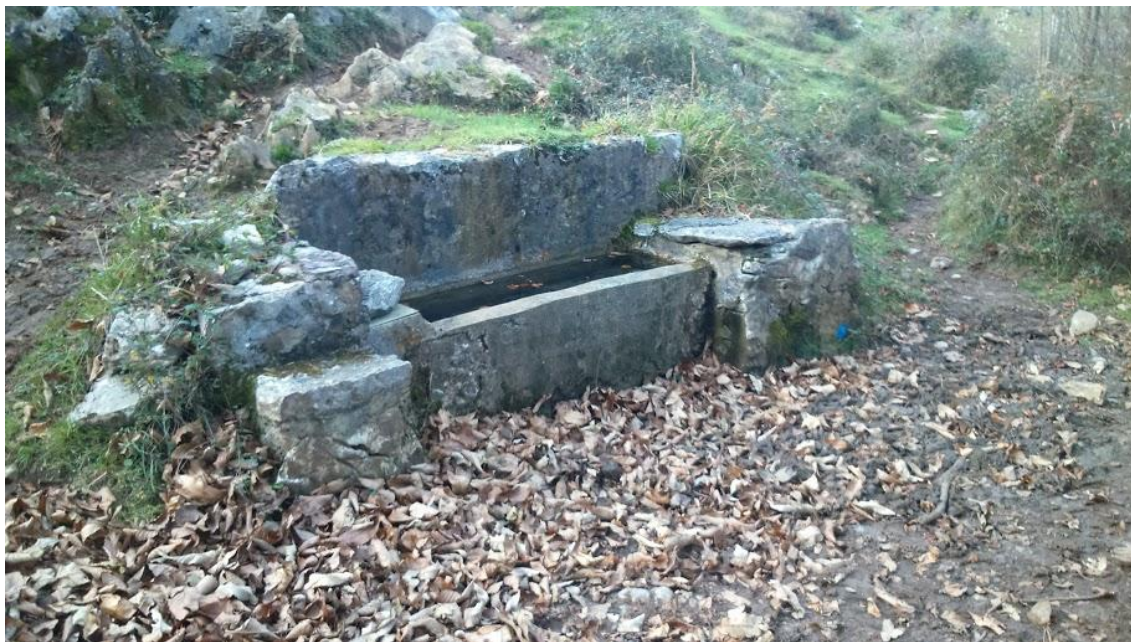
Foto 6: Bebedero del Pk 0+493 que será reconstruido.
